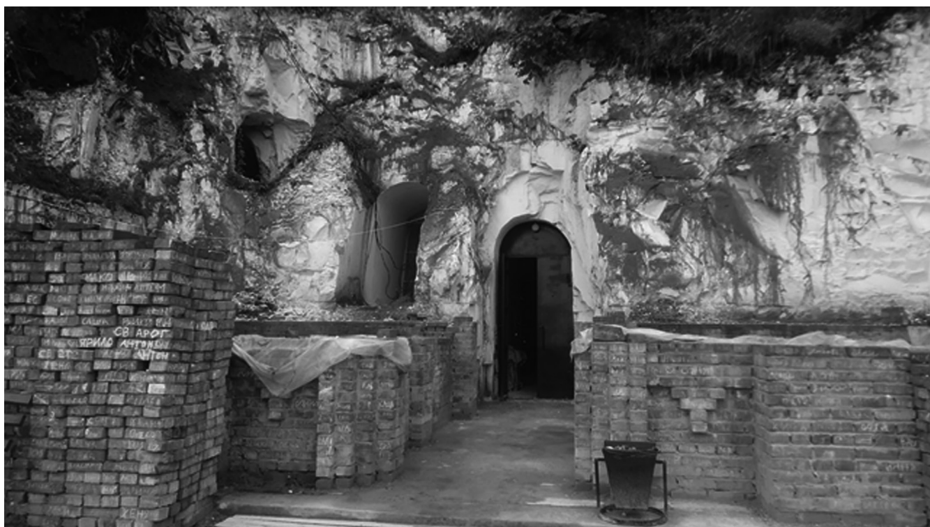
Рисунок 1 – Укрепление надвратной части пещеры
