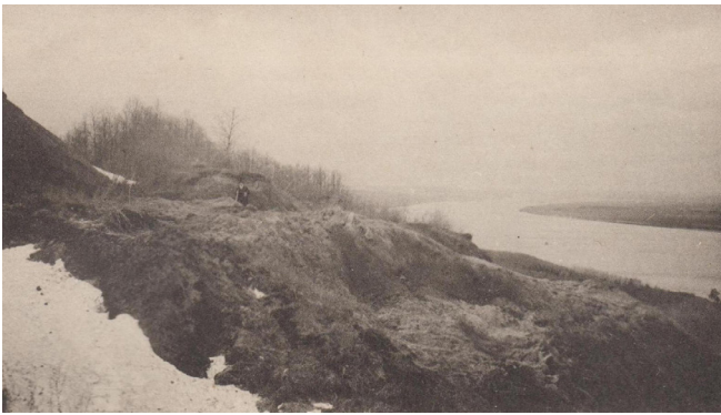
Рис. 1. Верхняя часть оползня (фото Павлова).
